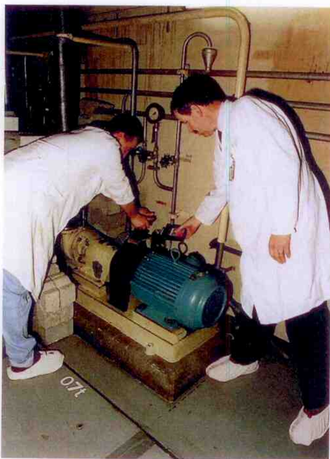
Werkzaamheden aan een radioactief-afvalwaterpomp onder begeleiding van de stralingscontroledienst
